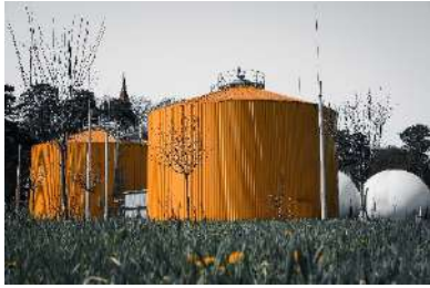
Între lumi (Metantancuri de la stația de epurare Feldioara. Aceasta este amplasată lângă cetatea medievală din localitate), Reinhard Rothbacher, S.C. COMPANIA APA S.A. Brașov
