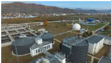
Stația de epurare Baia Mare (Este o stație mecano-biologică care asigură epurarea apelor uzate colectate din aglomerarea Baia Mare. Dispune de echipamente moderne atât pentru epurarea apelor uzate cât și pentru tratarea nămolului rezultat), Departamentul de Relații Publice, S.C. VITAL S.A. Baia Mare
