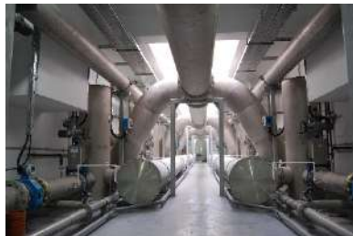
Labirint (Tehnologie modernă, filtre automate de nisip), Leonard Stefan Negrea, S.C. AQUASERV S.A. Tulcea
