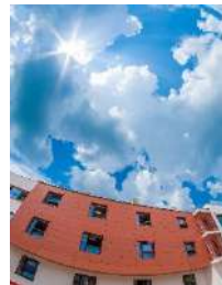
Sediul C.A. Aries (1) (Clădirea sediului central al societății, situată în municipiul Turda, clădire construită în anul 2016 din cota de cofinanțare a societății, fiind o condiționalitate impusă de Uniunea Europeană pentru obținerea fondurilor europene.), Paula Parlog, S.C. COMPANIA DE APĂ ARIEȘ S.A. Turda
