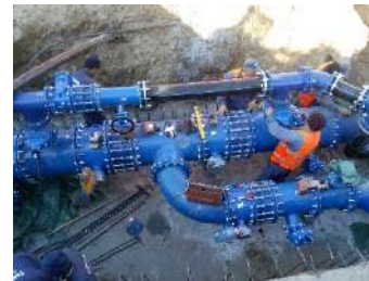
Nod hidraulic rețele apă (Fotografia reprezintă reabilitări ale rețelilor de apă într-un nod hidraulic, în vederea eliminării pierderilor de apă din zonă prin înlocuirea conductelor vechi cu conducte noi din fontă ductilă, amplasate într-un cămin cameră ce se află în lucru), Cătălin Mihai Ionescu, S.C. APĂ CANAL S.A. Galați
