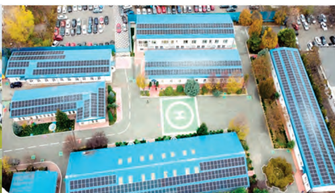
CEF Sediul Călărași / Calarasi PV Power Plant
