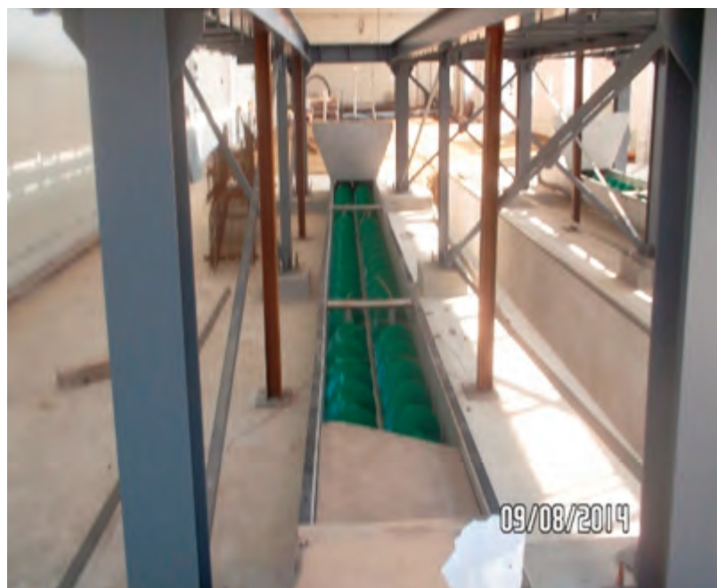
Fig. 9. SEAU Pitești - montaj echipamente Hală filtre presă / WWTP Pitesti - installation of Hall equipment filter press
