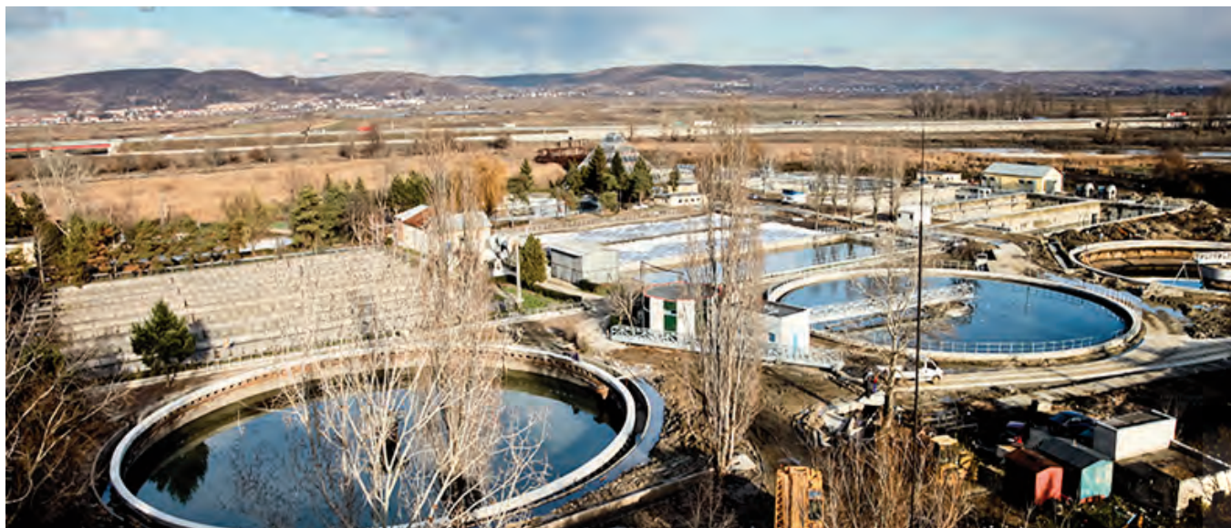
Fig. 1. Stație de Epurare Ape Uzate Pitești / Pitesti Wastewater Treatment Plant
