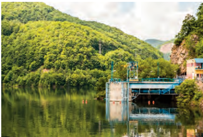
Fig. 1. Turnul de captare Tarnița / Tarnita capture tower
