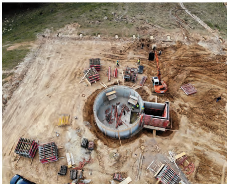
Fig. 11-12. Lucrări de construcții / Construction works
