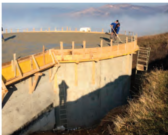
Fig. 10. Lucrări de construcții / Construction works
