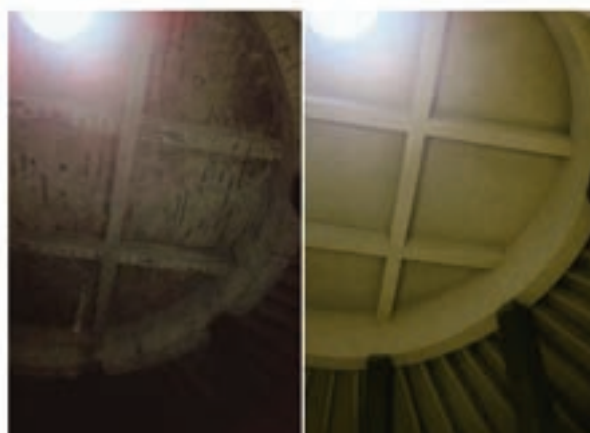
Figura 6., 7. Relevu fotografic (înainte / după) lucrările de reabilitare (exterior + interior) - rezervor semiîngropat 5,000 m 3 Valea Lupului / Figure 6., 7. Photographic survey (before / after) rehabilitation works (exterior + interior) - Valea Lupului 5,000 m 3 semiburied water tank
