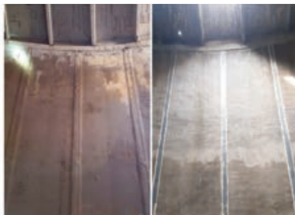
Figura 4., 5. Relevu fotografic (înainte / după) lucrările de reabilitare (exterior + interior) - rezervor suprateran 5.000 m 3 Miroslava / Figure 4., 5. Photographic survey (before / after) rehabilitation works (exterior + interior) - Miroslava 5,000 m 3 overground water tank
