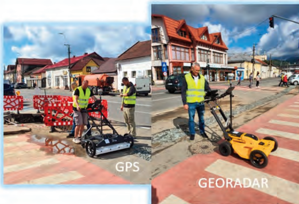
Fig. 6 - Echipamente pentru scanare subterană / Fig. 6 - Underground scanning equipment
